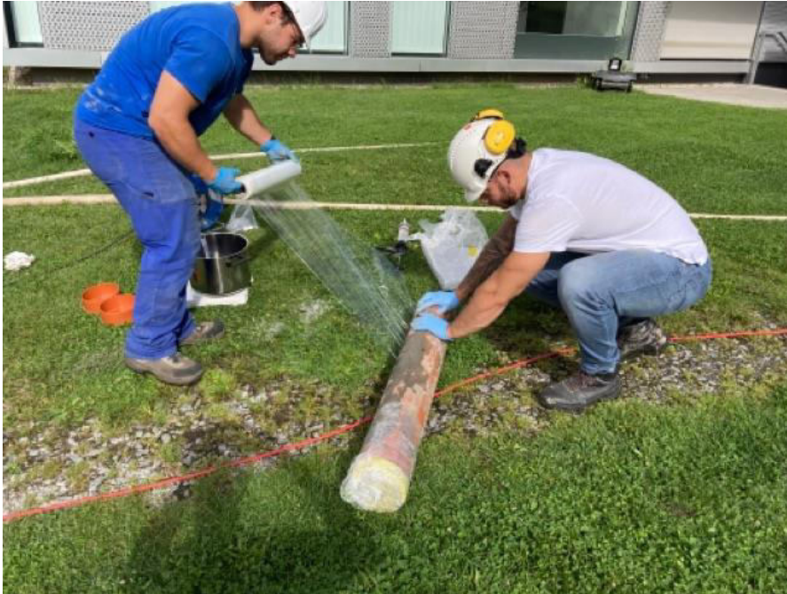
Zusätzliche Abdichtung mit Kunststofffolie, danach Gewebe-Tape an den Enden der Liner
