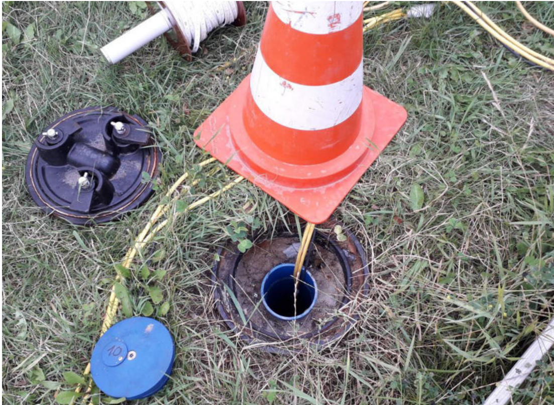
Abb. 25: Bereits erfolgter Einbau von 2 Feldsonden in GW10
