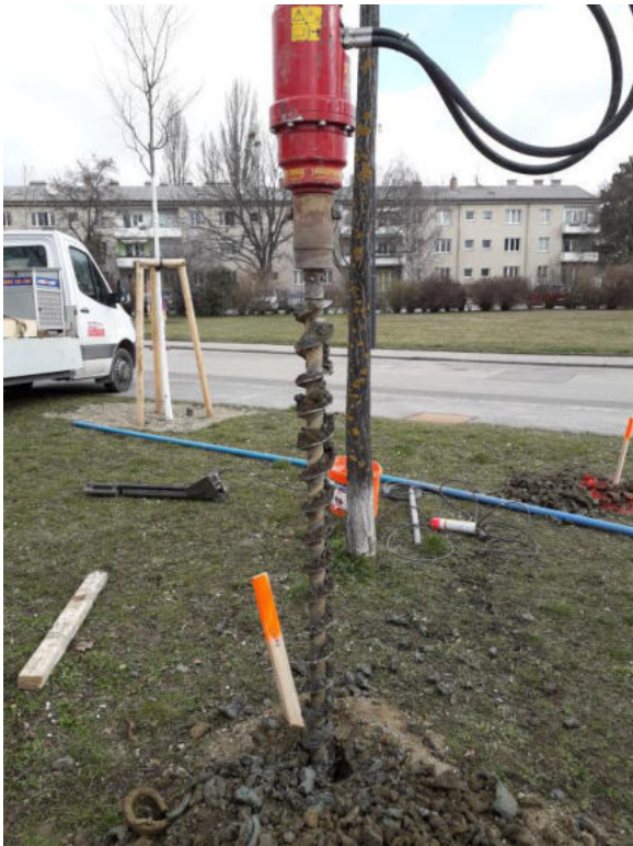
Arbeiten zur Kampfmittelfreigabe der Bohrpunkte
