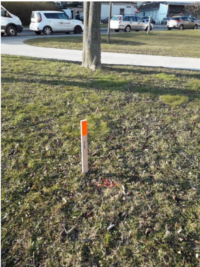
Beginn der Arbeiten: Bohrpunkte auspflocken
