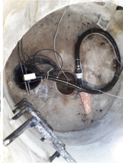
Bestandteile Sicherungsanlage: fixer Pumpeneinbau bei S44 (li) und S45 (re)
