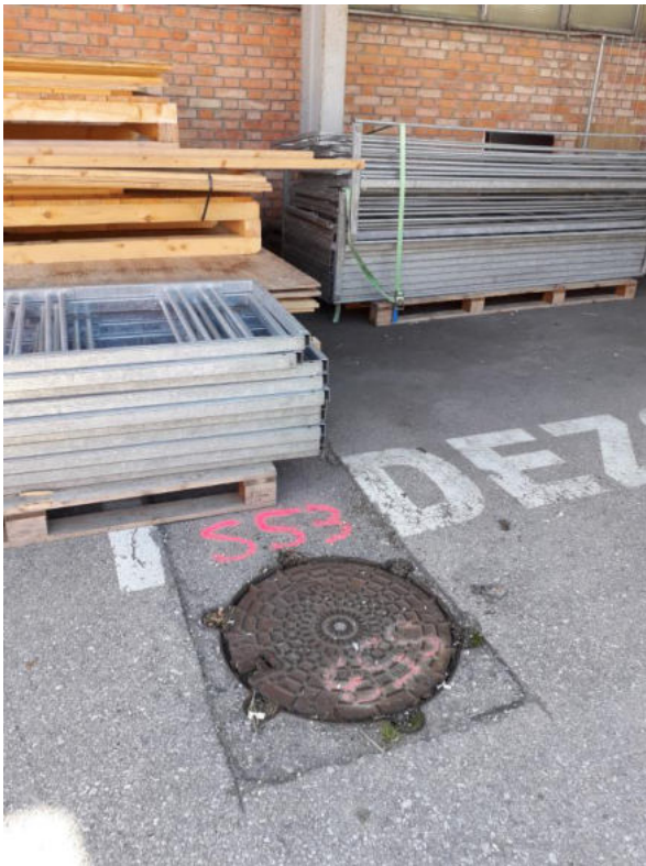
Benachbarte Pegel S53 und S52, Unterflur-Ausbau
