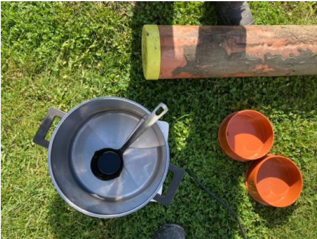
Flüssiges Parafin zur Abdichtung der Inliner-Kappen
