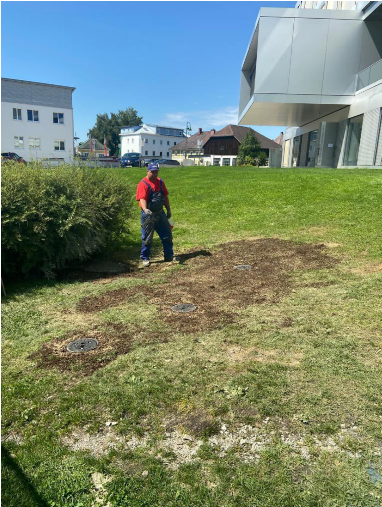
Fertige Unterflur-Pegel
