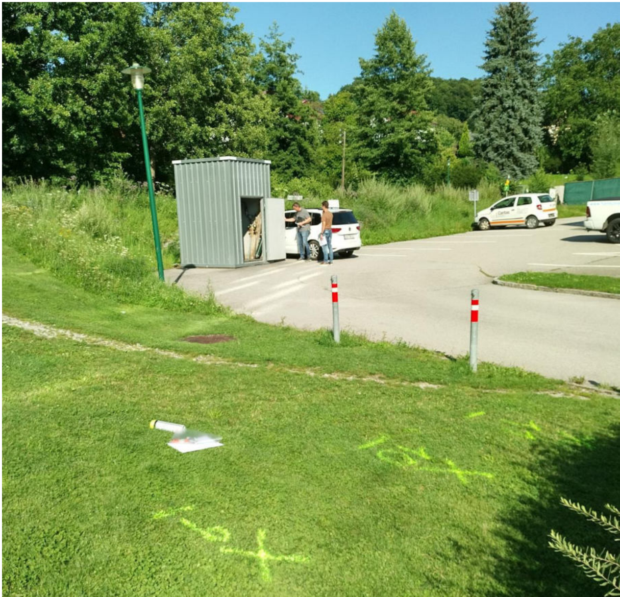
Markierung Bohrpunkte
