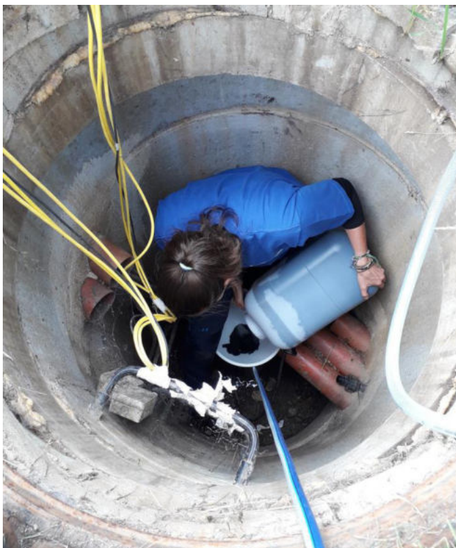
Abb. 32: Dotation Restmenge ZVI direkt in den Pegel GW08
