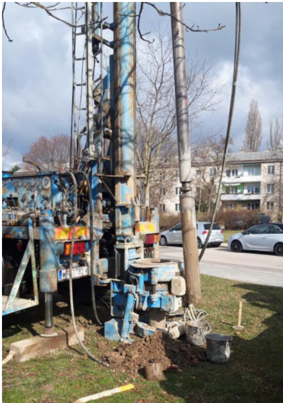
Bohrgerät bei der Errichtung von GW21
