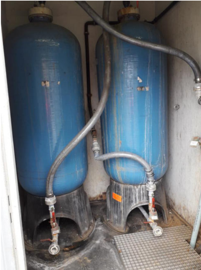
AK-Filter und Probenahmehahn der Sicherungsanlage
