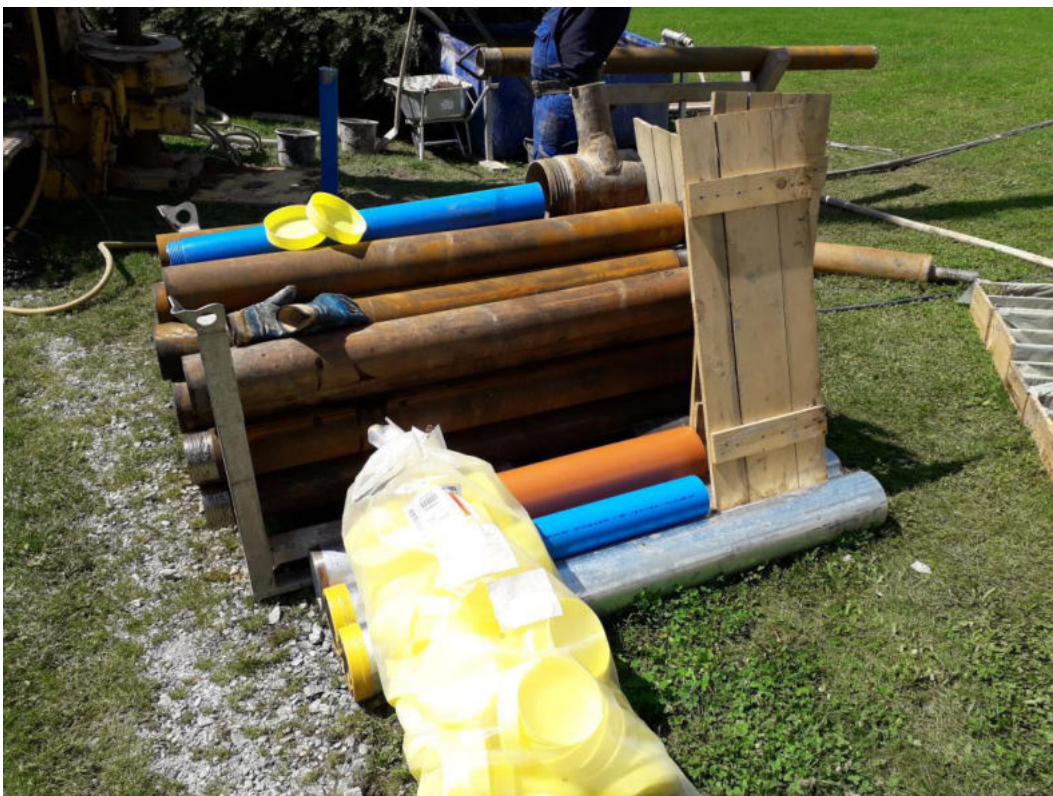
Bohrgestänge, Inliner, Kappen
