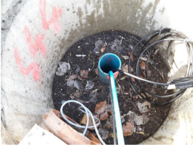
Bestandteile Sicherungsanlage: fixer Pumpeneinbau bei S44 (li) und S45 (re)
